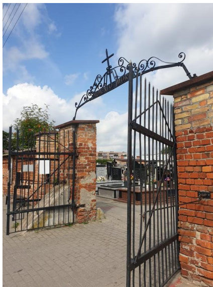
Rysunek 16. Widok na bramę wejściową Cmentarza rzymsko – katolickiego w Przasnyszu.
