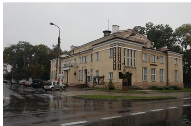
Rysunek 5. Widok na budynek przy ul. 3 Maja 16.
