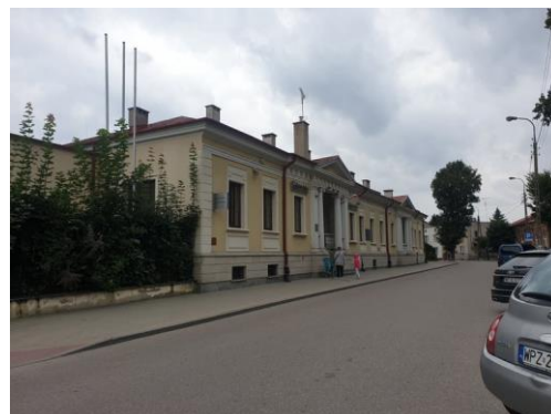
Rysunek 4. Widok na budynek przy ul. 3 Maja 13.
